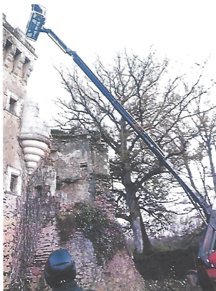
La sauvegarde de la tour Saint-Jean du château de Bourmont, nécessite de gros moyens. Ici, la grue de 16 tonnes en action.
